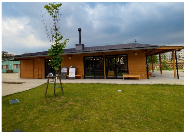
※泉北ラボの外観
